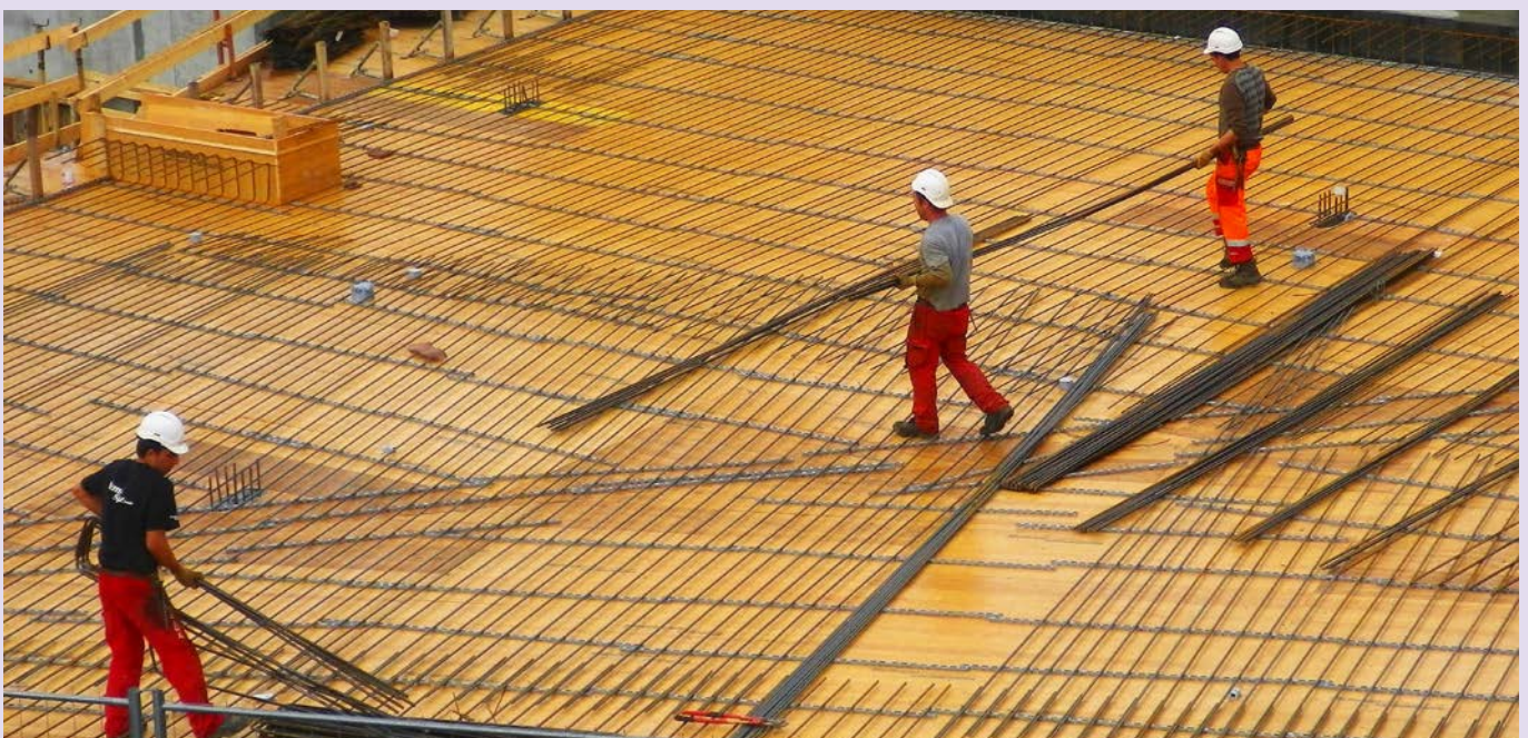
Bauherren, Architektinnen, Versicherer, Unternehmen, Logistiker: Es gibt eine Vielzahl von Akteuren, die auf dem Bau einwirken.
